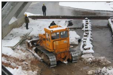
Ceļu būvei raksturīgs darbs dažādos apstākļos – arī ziemā.
