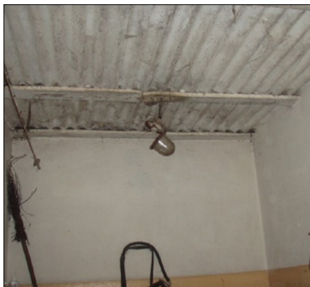
18., 19. attēls. Bojāta apgaismojuma vai elektrisko instalāciju lietošana rada gan ugunsgrēka, gan sprādzienbīstamības draudus
