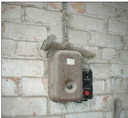
18., 19. attēls. Bojāta apgaismojuma vai elektrisko instalāciju lietošana rada gan ugunsgrēka, gan sprādzienbīstamības draudus
